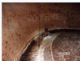
Cloque du revêtement d'étanchéité sur le voile de la cuve
